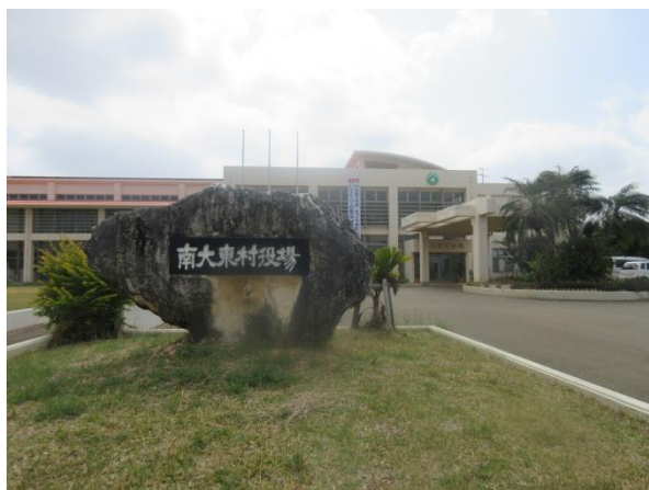
南大東村役場の建物
