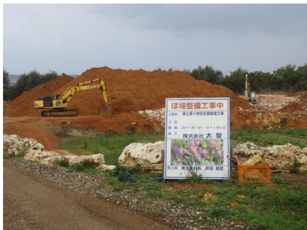
サトウキビ畑の圃場整備の工事現場
