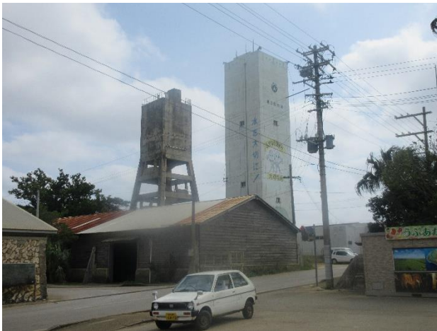
「水を大切に」と書かれた給水塔
