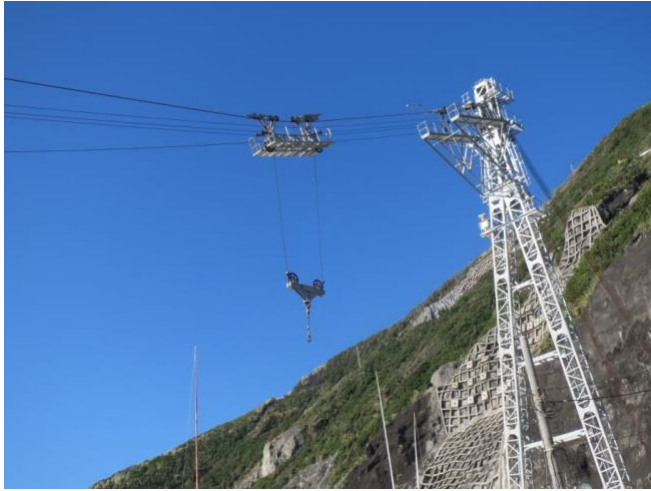
漁船を引き上げる巨大なクレーン
