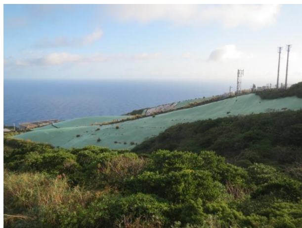
緑色に塗られた簡易水道水の集水面
