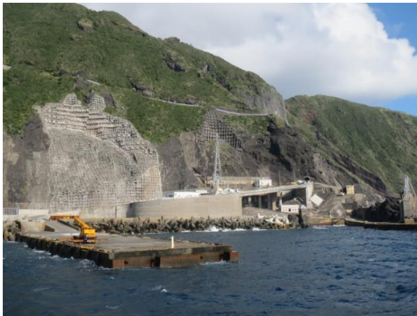
断崖絶壁に築かれた青ヶ島港
