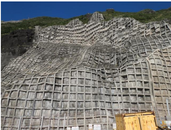
背後の崖をコンクリートで固めた三宝港
